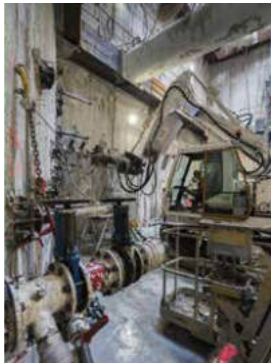
Figure 15 : Atelier de forage de congélation avec SAS en premier plan - Freezing drilling work area with air lock in the foreground
