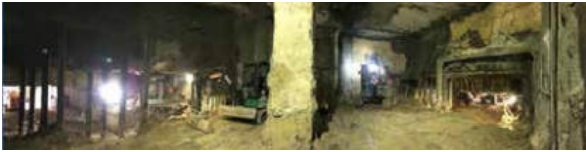
Figure 3 - 4 : Vue panoramique du tunnel excavé sous le RER C, avec la barrette B11 au centre - Panoramic view of the tunnel excavated under RER C, with the B11 bar in the centre
