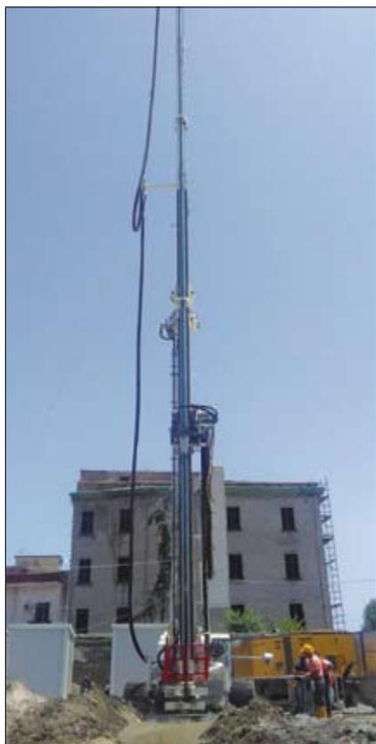
La perforatrice idraulica Casagrande C16XP, fornita alla I.CO.P. per eseguire un tappo di fondo di jet-grouting della stazione di Poggioreale, è allestita in modo da garantire perforazioni con mast in verticale fino a 36 m in battuta unica
