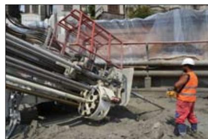
La perforatrice idraulica Casagrande C8XP impegnata nel cantiere di Poggioreale. Posizionata nell'area adiacente il Cimitero Monumentale di Napoli, è adibita alla realizzazione di un'ampia serie di fori inclinati, eseguiti "a ventaglio", per il consolidamento di una vasta area sotterranea non accessibile con metodi tradizionali di perforazione verticale
