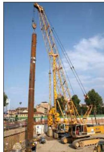
zionamento. Il piano dei cordoli guida (piano di lavoro) è stato collocato alla quota +244,80 s.l.m, cioè 2 m al di sotto di quello originario. Per impedire smottamenti o cedimenti delle aree limitrofe al cantiere, in particolare corso Inghilterra, via Cavalli e corso Vittorio Emanuele, è stata realizzata una preventiva palificata di micropali di diametro 250 mm e profondità 7 m. Un cordolo sommitale in c.a. ha poi garantito la necessaria stabilità.
