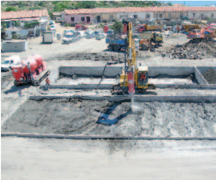
Figura 3. Stabilizzazione di massa in vasche prefabbricate (trattamento ex situ)
