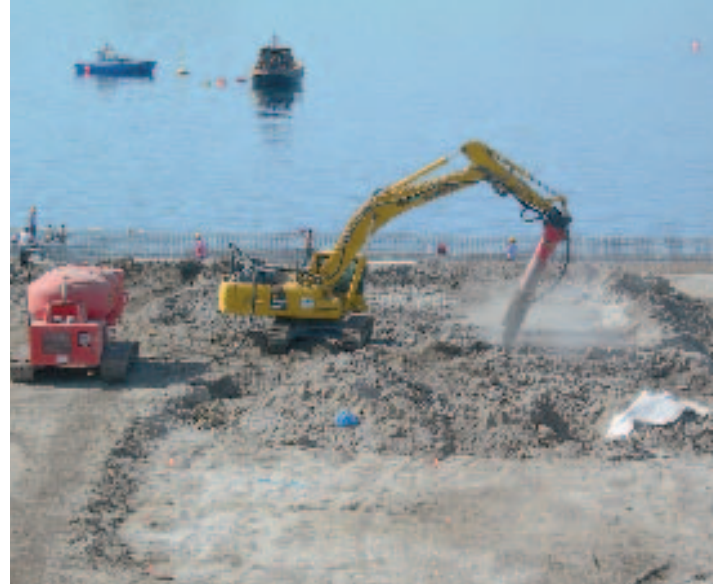
Figura 2. Stabilizzazione di massa in vasca di colmata (trattamento in situ)
