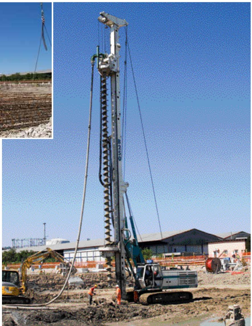
zabili su un monitor di chiara leggibilità, mentre la macchina è anche dotata di un datalogger per registrare i parametri di scavo e di risalita e controllare l'iniezione di calcestruzzo.
