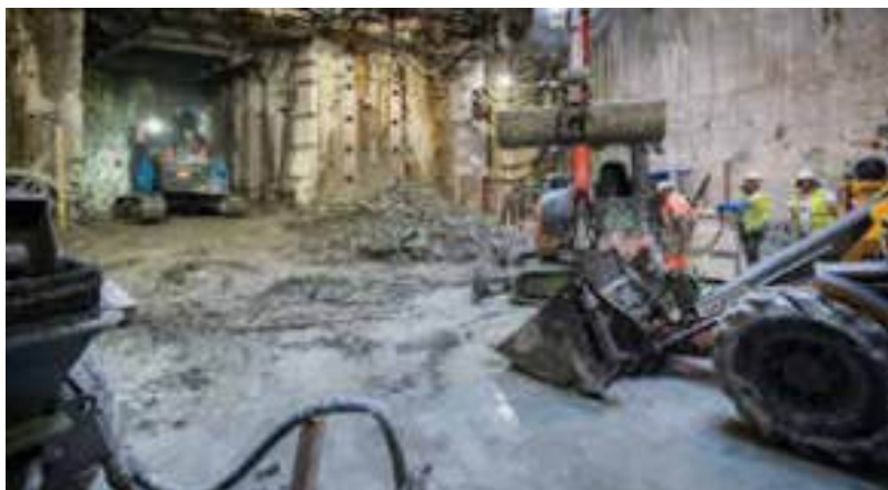
Figure 8 : Début du creusement de la galerie G1, côté BAM - Start of the excavation of the G1 gallery, BAM side
