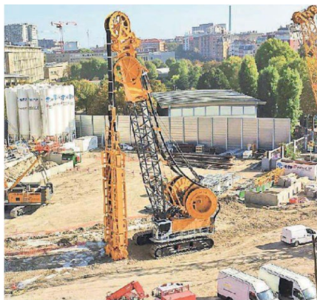
Uno scorcio del cantiere della nuova metro di Parigi
