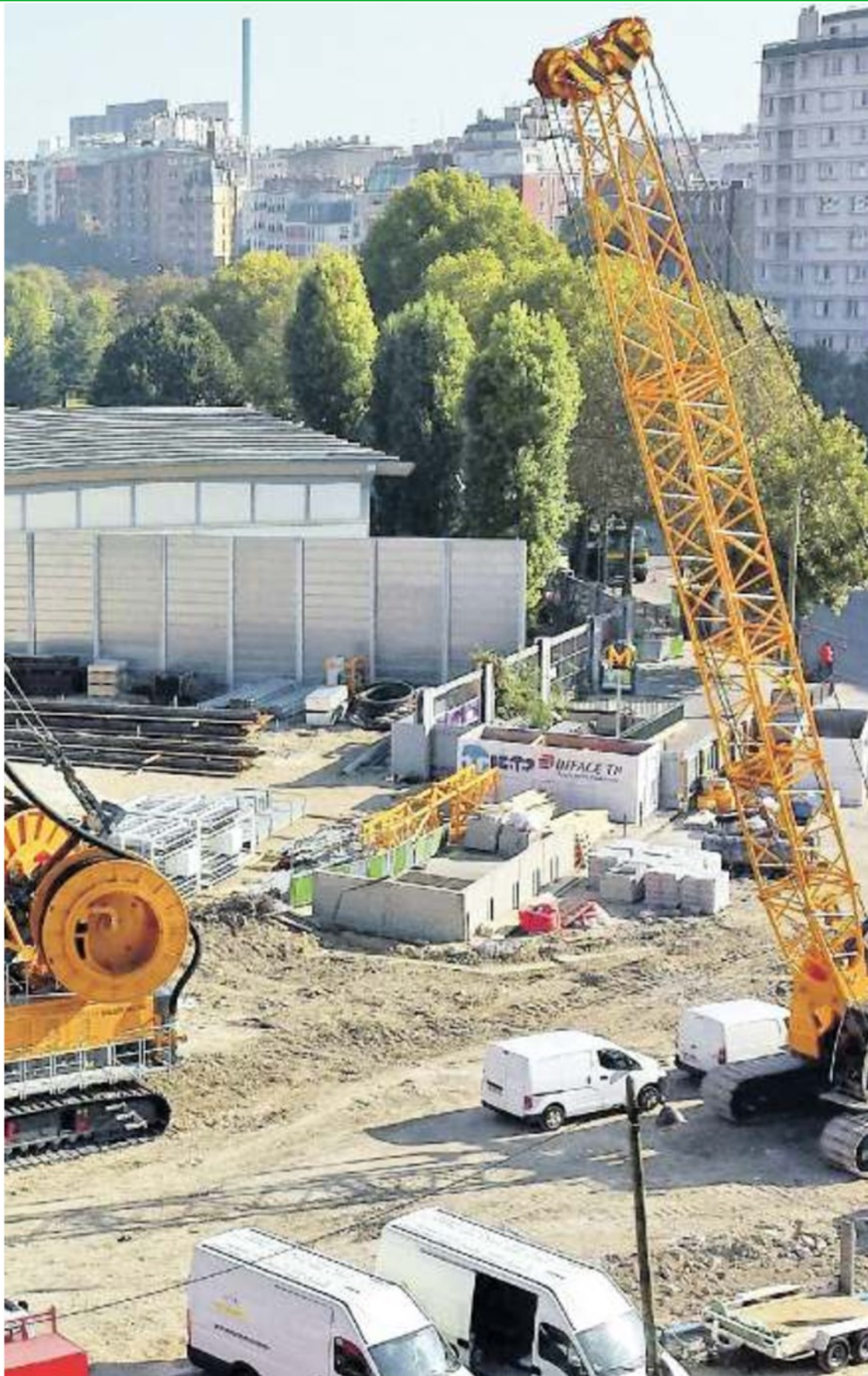
CANTIERE I mezzi al lavoro per l'importante opera in fase di realizzazione
